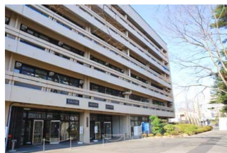
図9 材料科学総合学科です。先端材料解析学研究室は4階の裏にあります。
